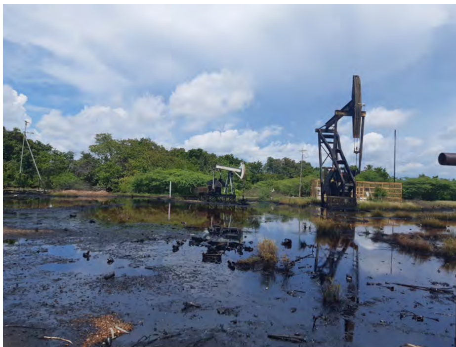
Figura 14. Pozo petrolero abandonado en el barrio R1 de Cabimas, estado Zulia. Fuente: OEP (2022)
