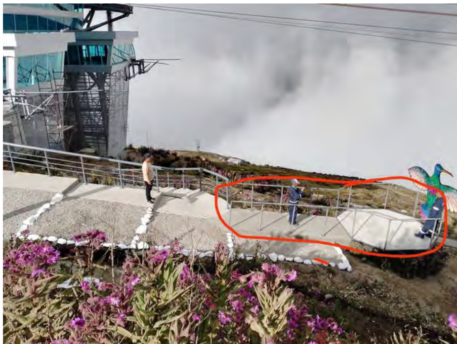
Figura 55. Estructura metálica en el Parque Nacional Sierra Nevada Fuente: Redes Social Fiscalía de la República (2022)
